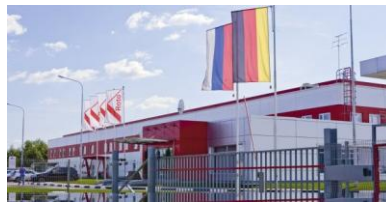
Производственный комплекс 12 000 м 2
