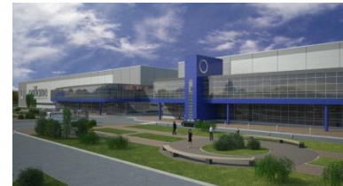
Производственный комплекс и склад-110000 м 2
